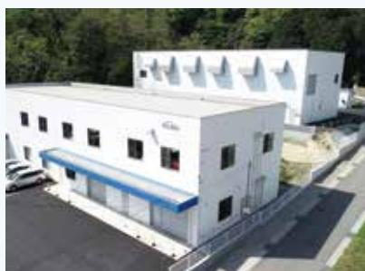
西湘テクニカルセンター
