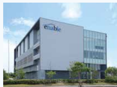
神戸テクニカルセンター
