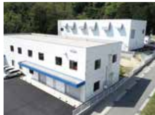
西湘テクニカルセンター
